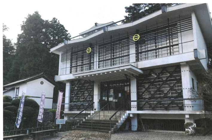
富士山一清が1963（昭和38）年に建設し、七尾市に寄贈した「七尾城史資料館」。先祖である守護大名富士山家の関連資料を公開している＝七尾市古屋敷町
